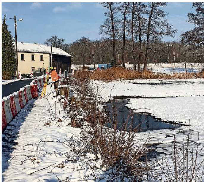
Baustart zur Sicherung der Teichböschung in Kleinnaundorf
