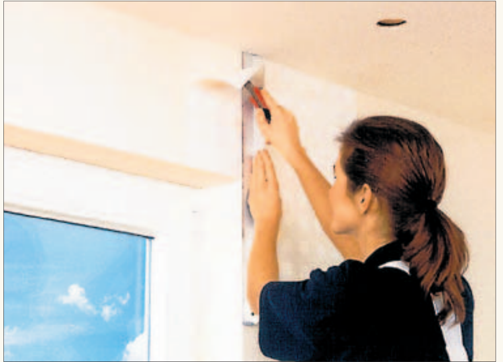
Exaktes Arbeiten beim Tapezieren - Überstände lassen sich mit Hilfe eines Lineals und Cuttermessers abschneiden. Foto: dpa/ gms
