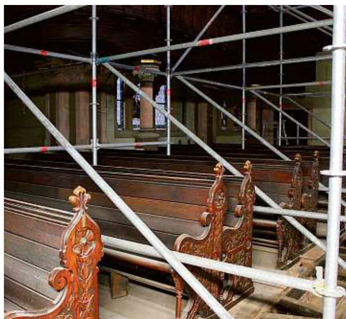
Blick in den Kirchenraum, der ebenfalls saniert wird.
