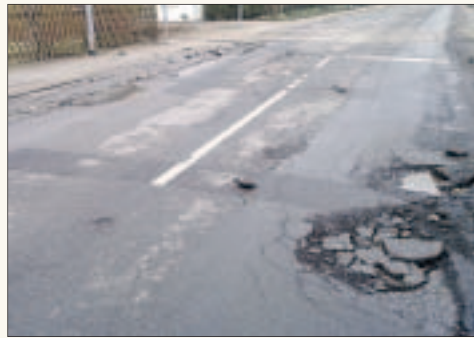
Nach dem Winter folgen die Reparaturen.
