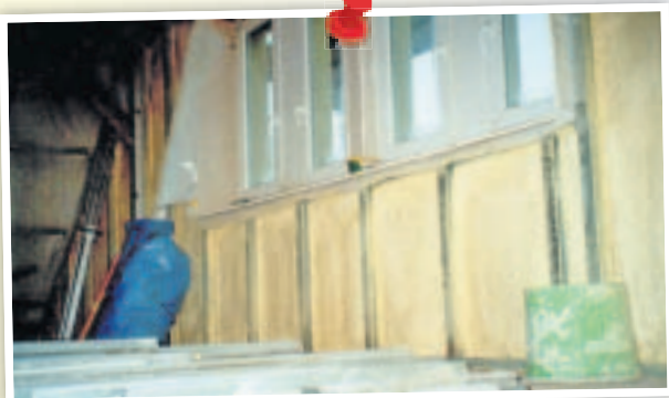
Sprühschaumbeschichtungen der Firma ipurtec aus Strehla bei Riesa werden nicht nur in Wohnhäusern eingesetzt. PUR-Dämmung ist resistent gegen Schimmel. Fast jeder Untergrund eignet sich. Fugen und Lücken gibt es nicht.
