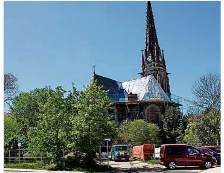
Eingerüstet für eine aufwendige Sanierung. Die Johanneskirche ist in der Reihe der bekannten Meißner Kirchen der vorerst letzte Kirchenbau, der restauriert wird.
