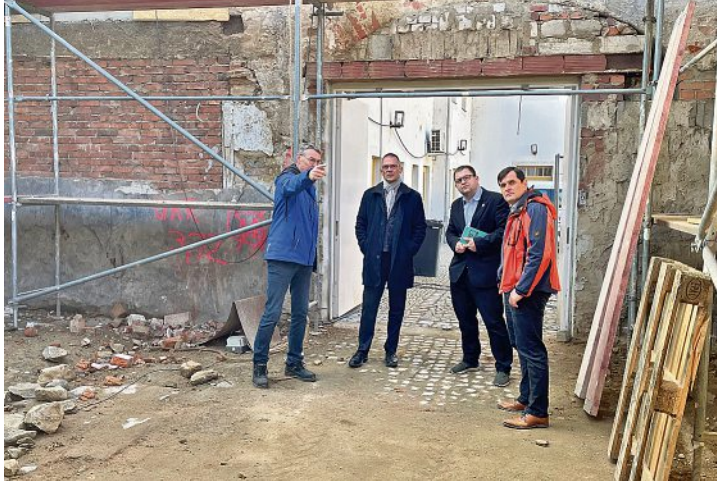
Bauamtsleiter Hagen Nickol, Landrat Ralf Hänsel, Hauptamtsleiter Robert Wölk und Bürgermeister Jörg Jeromin (v. l.) auf der Baustelle der Rathausscheune in Strehla
