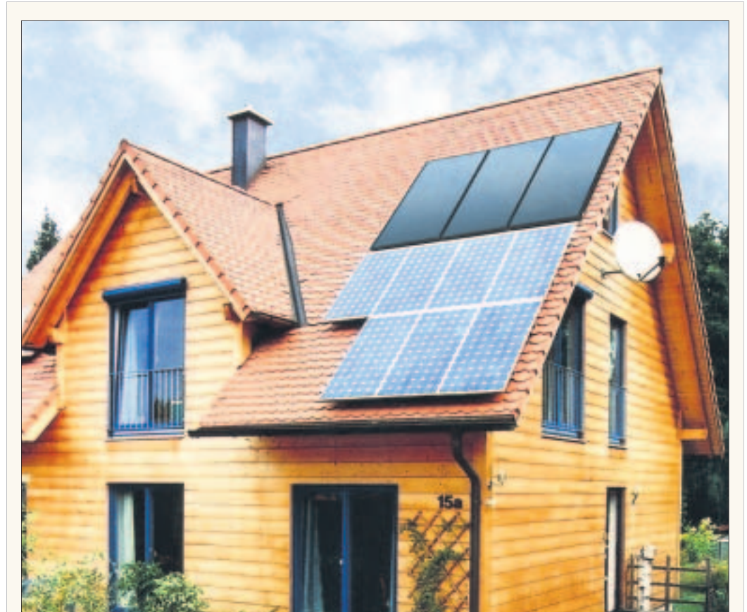
Eigenheim mit einer solarthermischen Anlage (schwarzer Kollektor oben) und einer Photovoltaik-Anlage (darunter) am Schrägdach installiert. Beide Formen der solaren Nutzung lassen sich auch in Kombination gut betreiben.
