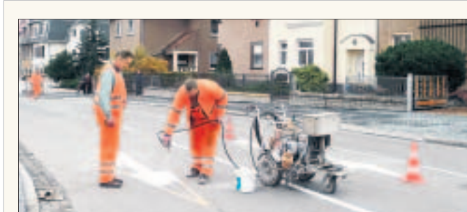
Kreisstraßenbau, wie hier auf der Weßnitzer Straße in Großenhain, gehört seit 1990 zu den wichtigsten Aufgaben der Landkreise. Jetzt wird Bilanz gezogen.
