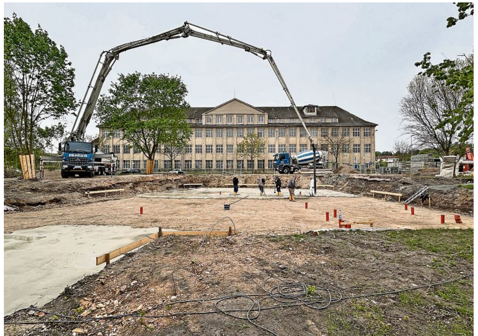
Am 19. April wurde gerade die Bodenplatte gegossen.
