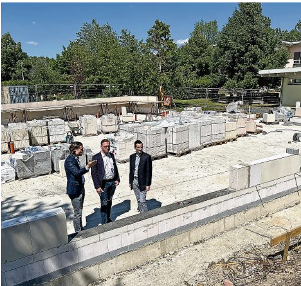
Dr. Manuel Hentschel (Leiter des Amtes für Hochbau und Liegenschaften), Schulleiter Lars Röder und Stefan Noack genannt Gräfe (Leiter des Kreisschul- und Kulturamtes) (v. l.) bei der Fortschrittskontrolle auf der Baustelle Mitte Mai
