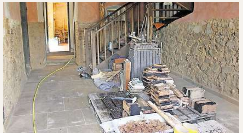
Blick in ein denkmalgeschütztes Fischerhaus in Meißen nach der Flut.
