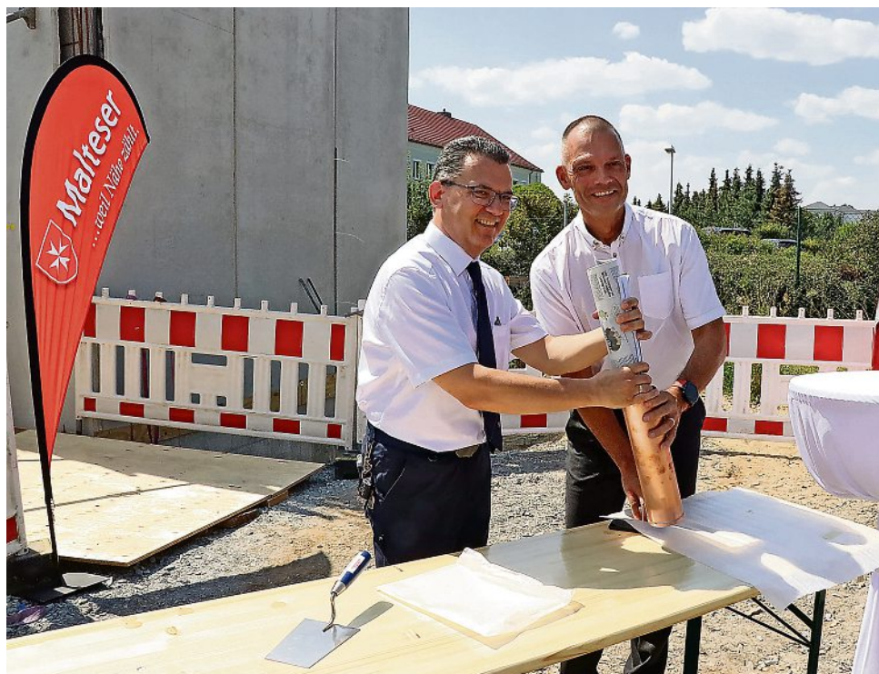
Rene Fleischer (l.) und Landrat Ralf Hänsel befüllen die Hülse für den Grundstein der Rettungswache Großenhain.
