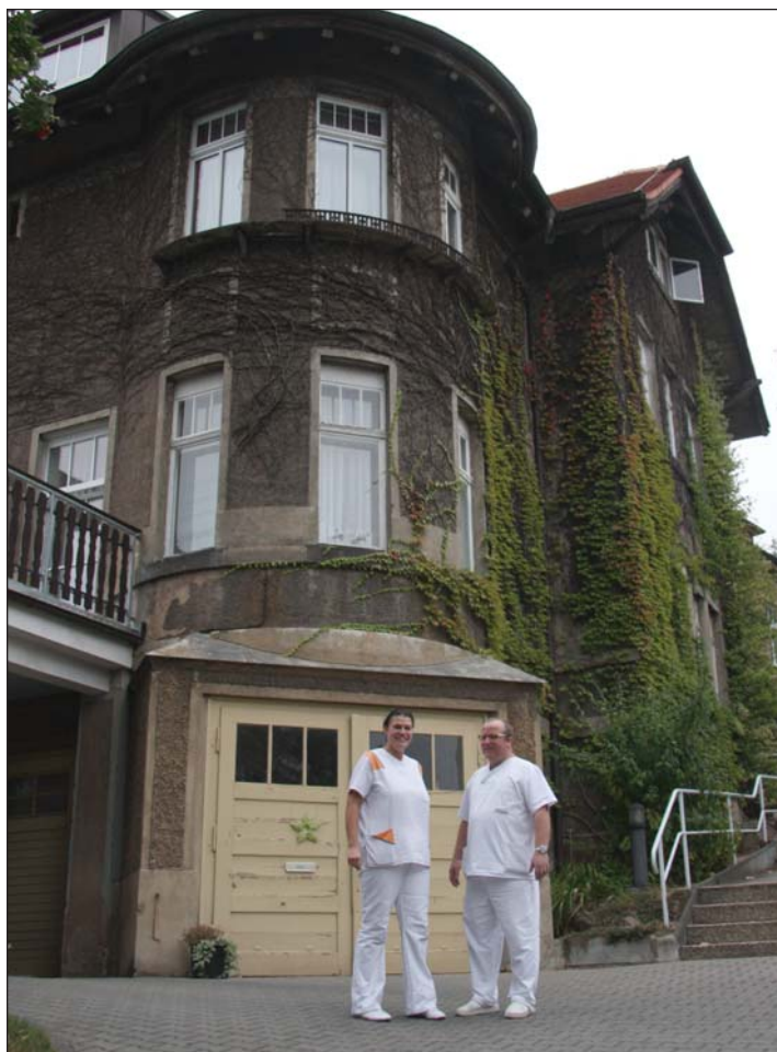
Beim ASB in Radebeul arbeiten Sozialstation und Tagespflege unter einem Dach und koordinieren die Betreuung der Patienten. Hier im Bild der Leiter der Tagespflege Ralf Donaubauer und Schwester Conny Lehmann.
