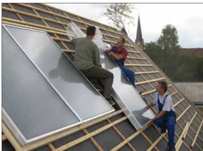
Montage von thermischen Solarkollektoren → Die Sonne nutzen kann sich lohnen.
